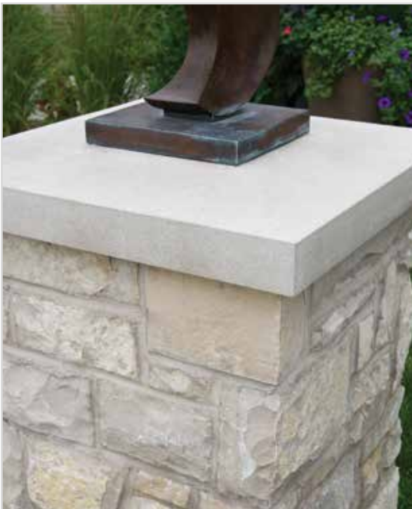
Square edge pier cap.
